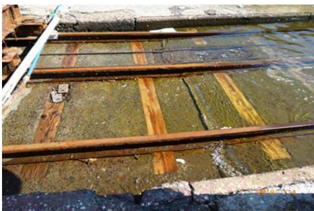
Fig. 8 君沢型建造の名残を留める進水軌条と枕木（Fig. 7の正面部分。すぐ山が迫っている。筆者撮影）
