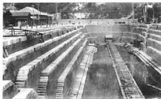
完成した浦賀ドライドック (明治32年)
