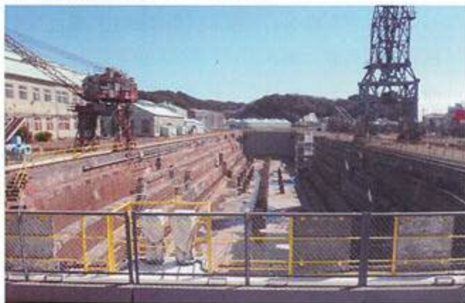
貴重な文化遺産でもある煉瓦積みのドライドックの現況 (塀の上から筆者撮影)。奥がドックゲート。右手のクレーンは赤さびアームは無い
