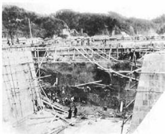
浦賀ドライドック掘削工事 (明治32年)
