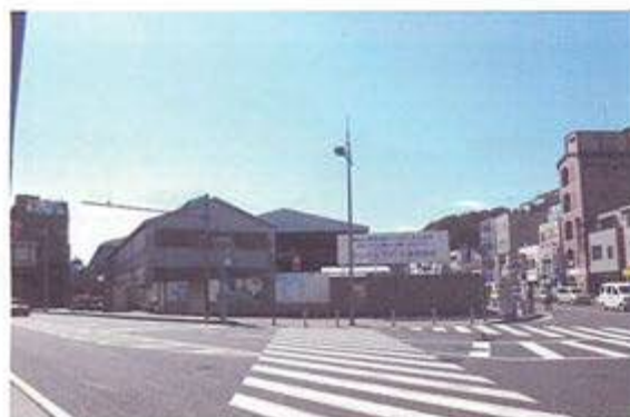
浦賀駅前から見た旧浦賀ドックの建屋（正面の傾斜屋根）（2014年3月筆者撮影）
