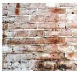
ポンプ室のレンガ積み
