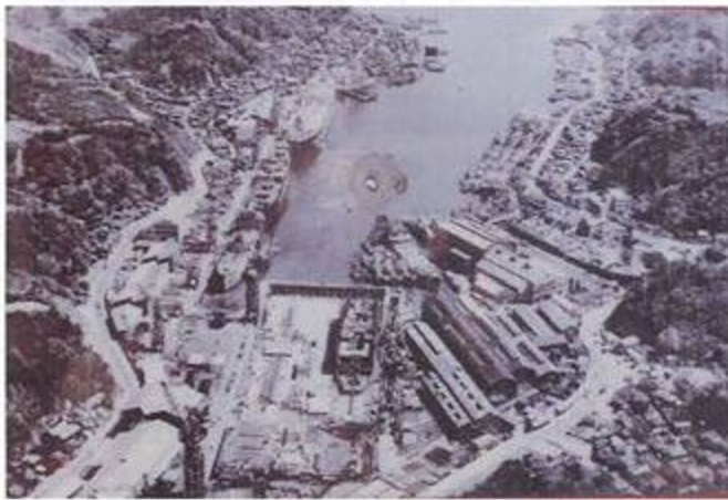
1950年代の浦賀ドック全景 (「浦賀・追浜、百年の航跡」より) [以上の写真・文章は屋外掲示より筆者撮影] 中央左に進水台が2条、右手斜めにドックが見える。進水台のうち右側が日本丸 (II世) の建造・進水に使用されたものであろう
