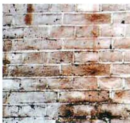
ポンプ室のレンガ積み
