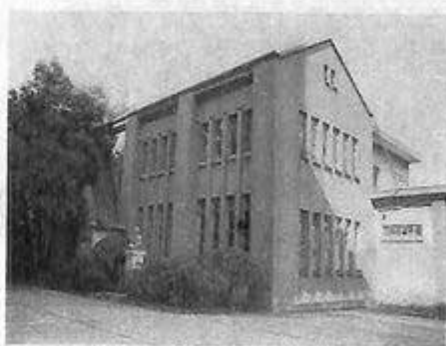
現在の水槽外観（昭和52年）
