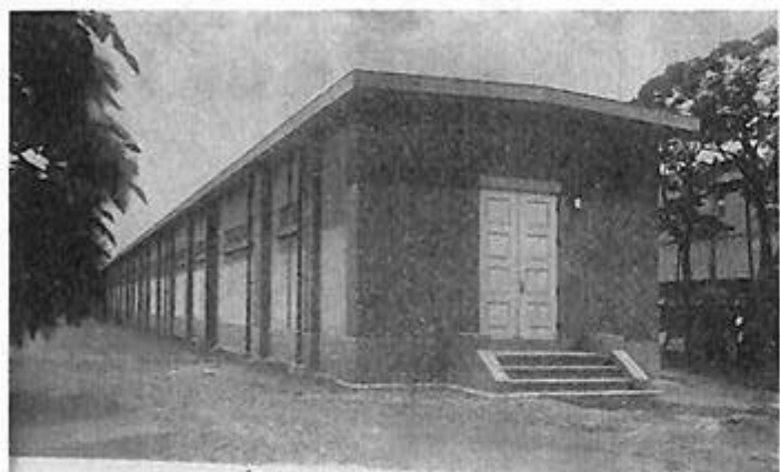
竣工時の水槽外観（昭和12年7月）
