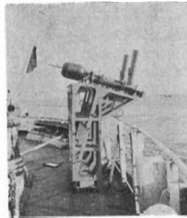
Photo 6 波高計ランチャ (三連装であるが、一発だけ充填されている。)
