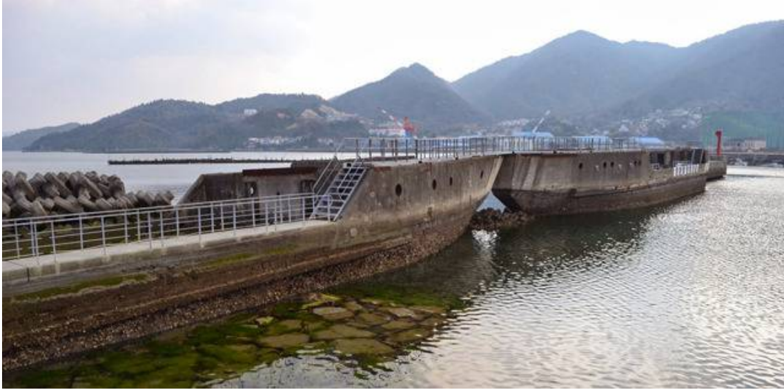
図の左が陸地に接した第一武智丸、右が第二武智丸で両船は船尾を接して沈設されている。 第2武智丸の先に港の入り口を示す灯標が設置されている。
