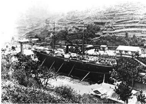
図 3-2 上架作業中の汽船
