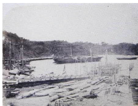
図 4-2 横須賀製鉄所：工事中の修船架
