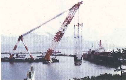
▲写真3 むつ船体から切り離され、遮へい体ごと一括で陸揚げされた原子炉室は、「むつ科学技術館」に展示。覗き窓から原子炉格納容器の内部が観察可能
