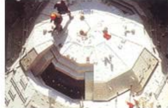
工事中の格納容器上部遮蔽体
