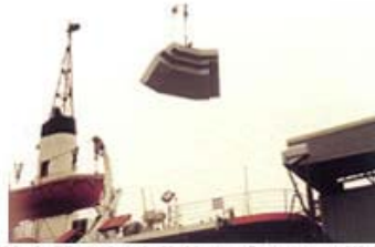
格納容器上部遮蔽体(cブロック)の搭載
