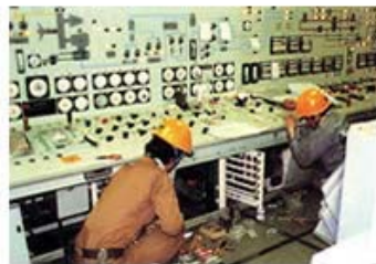
中央制御盤の改造工事
