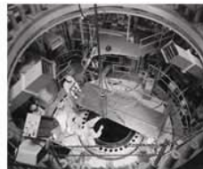
核燃料の装荷：47年9月3日から 6日にかけて燃料集合体32体と中 性子源4体が原子炉容器内に装 荷されました
