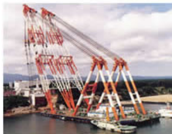
起重機船により原子炉室を保管建屋へ移送
