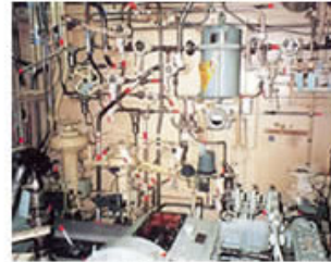
原子炉補機室内機器類撤去工事の準備
