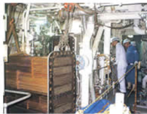
総合熱交換器の解放点検
