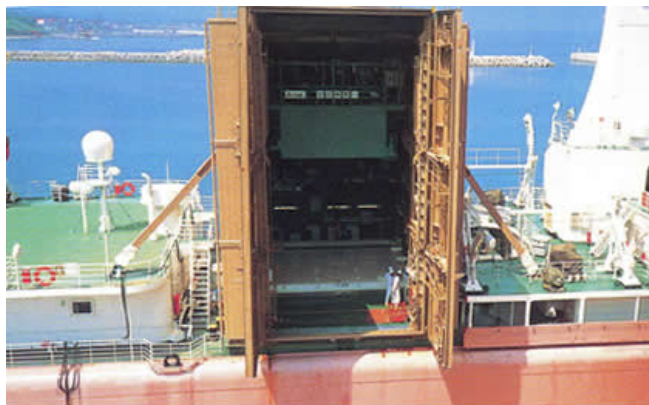
原子炉容器蓋解放点検のため設置された船上補助施設
