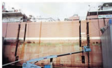
原子炉室一括撤去のために船体を切断
