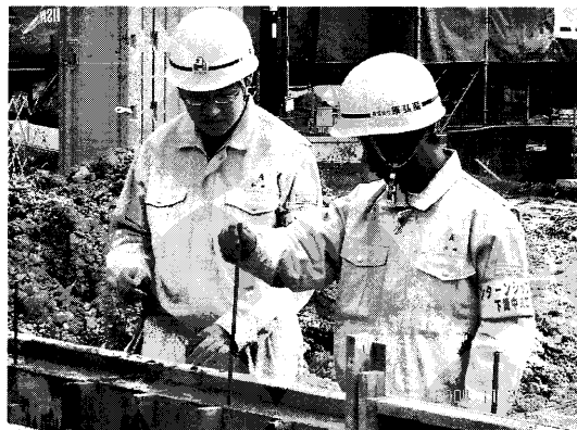
建築現場での基礎工事
