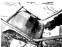
FRP で固定中
