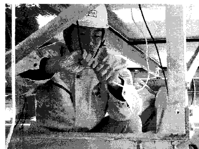
Picture 6.配線工事
