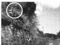
【⑨設置場所(丸印が外灯)】
