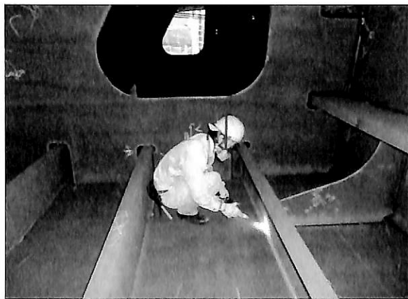
船体ブロック構造、品質確認検査
