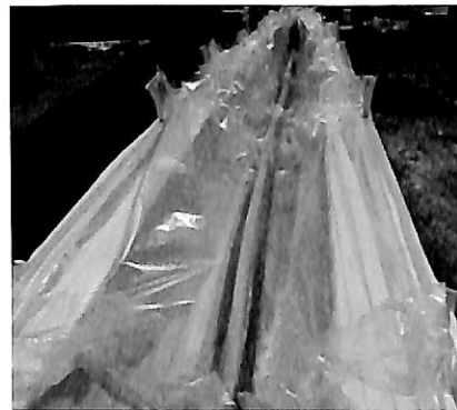
写真 1 6 VIP工法 写真 1 5(左) オス型
