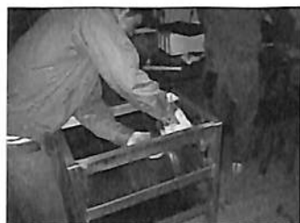
図 25 天板の取付作業
