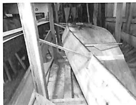
写真 21 タナ板の取り付け
