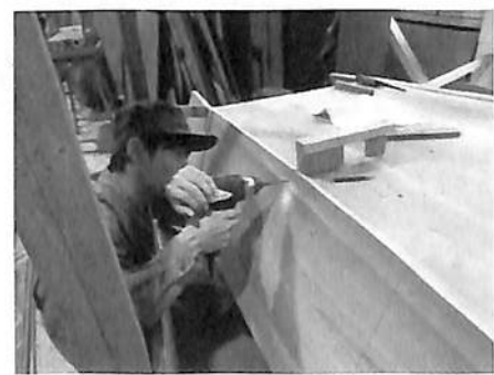
写真 22 釘穴をドリル
