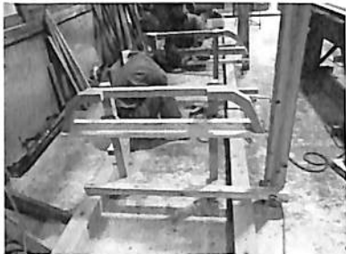
写真 17 フレームの組立
