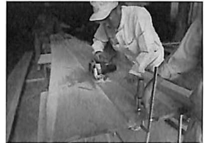
写真5 船底板の切断
