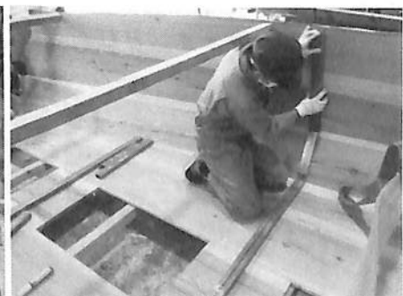
写真3 フレーム製作
