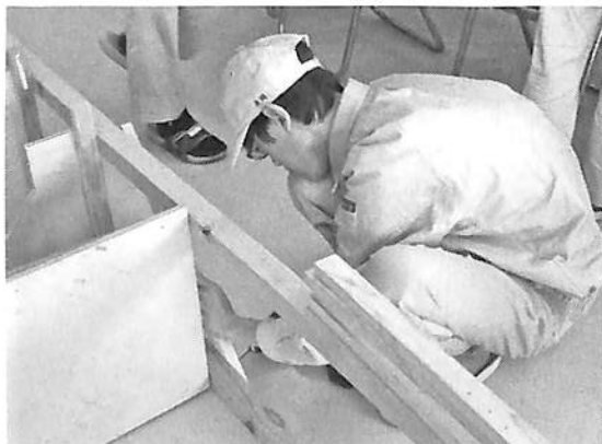
(電動ドリルの下穴開け作業)
