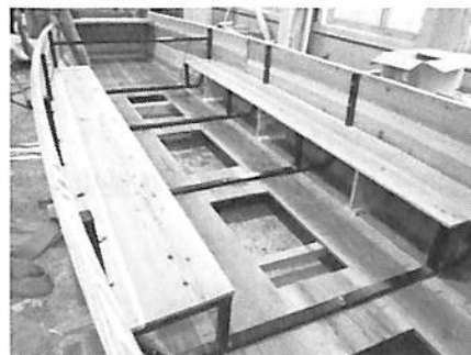
写真16 船底に開けた開口部
