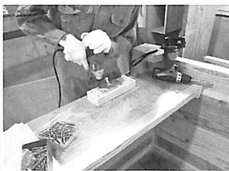
写真14 櫓べその取り付け
