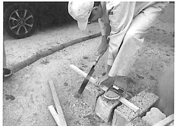
(角材の切断の様子)
