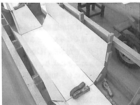
(区画の合板にのり代となる角材をつけた様子)
