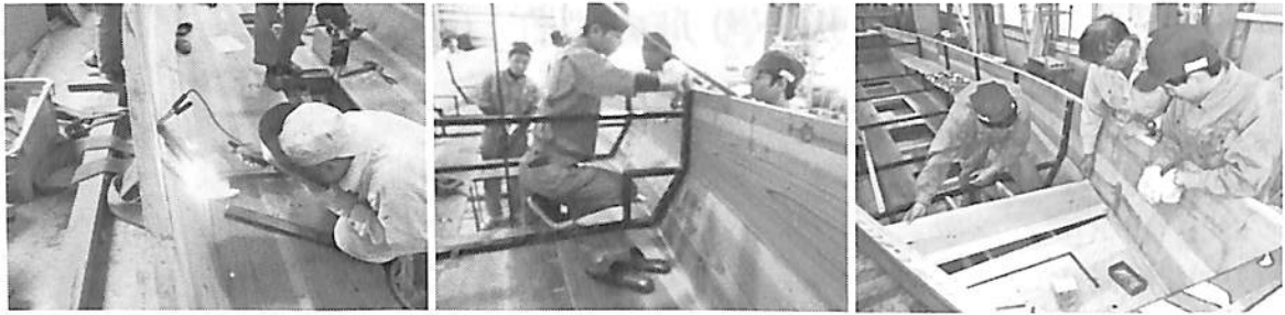
写真4 フレームの仮止め 写真5 フレームの取り付け 写真6 船首デッキ取り付け
