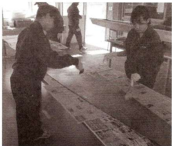
(デッキ部材にエポキシ樹脂を塗布)
