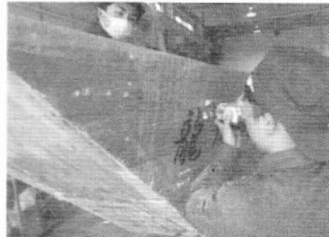
写真3 タナの切断
