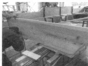
写真5 トダテの取付
