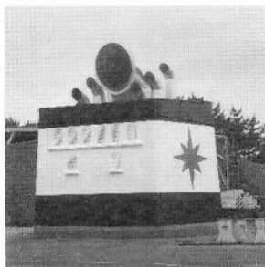
写真：ファンネル(煙突)
