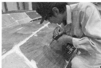
( 内枠製作作業 )
