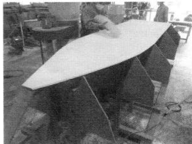
写真3 船底板の取り付け
