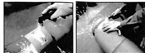
図15 プラズマ切断
