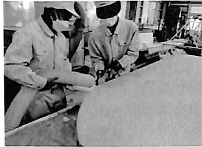
写真8 ボードの切断
