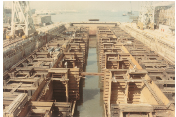
写真2 3次元増トン工事で中心線部船体を挿入するために上部船体を取り除き、拡幅したところ（乾ドック内）。
