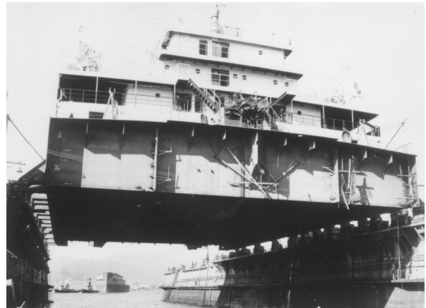
写真1 ESSOタンカーの2DE工事で上部船体が浮きドックに預けられて中空高く残った。ドックから引き出された下部船体が後方に見える。
