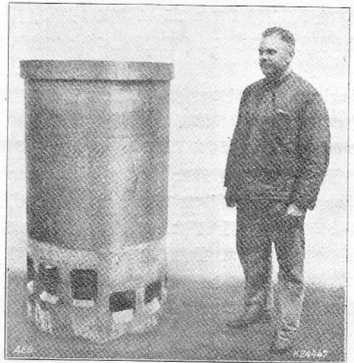
Fig. 4. Nitriergehärtete Zylinderlaufbuchse einer doppeltwirkenden Zweitaktmaschine.
