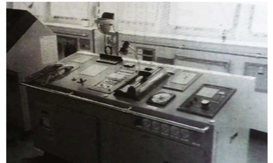
10) W68-10 サンチアゴ 冷凍装置監視盤
