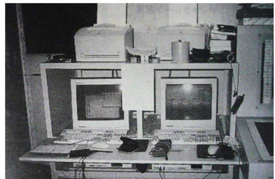
33) W73-33 ATLANTIC REEFER 冷凍機監視システム
