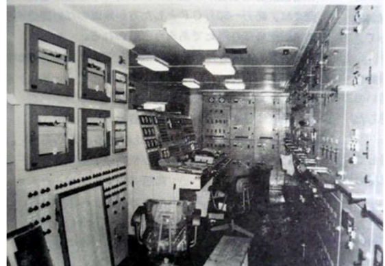
15)W58-15 倉島丸 機関制御室
