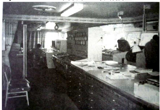
6) W63-06 国東丸 中央制御室
